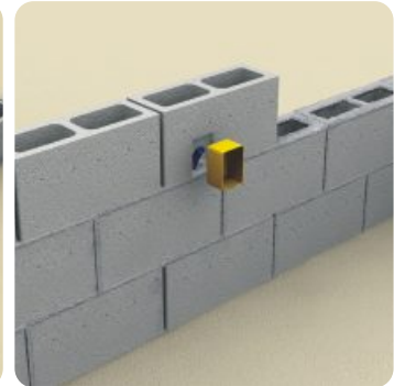
Assentamento de bloco elétrico
